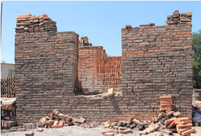
Horno ladrillero momento previo antes de la colocación de ladrillos crudos.
