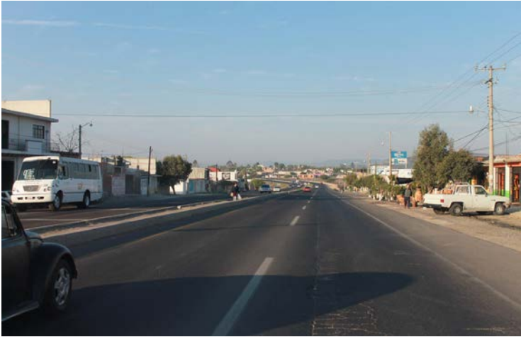
Figura 6. Carretera Tequisquiapan a San Juan del Río, Querétaro.
