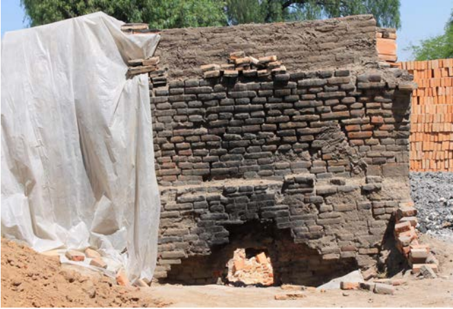
Horno ladrillero, momentos antes de encenderse.
