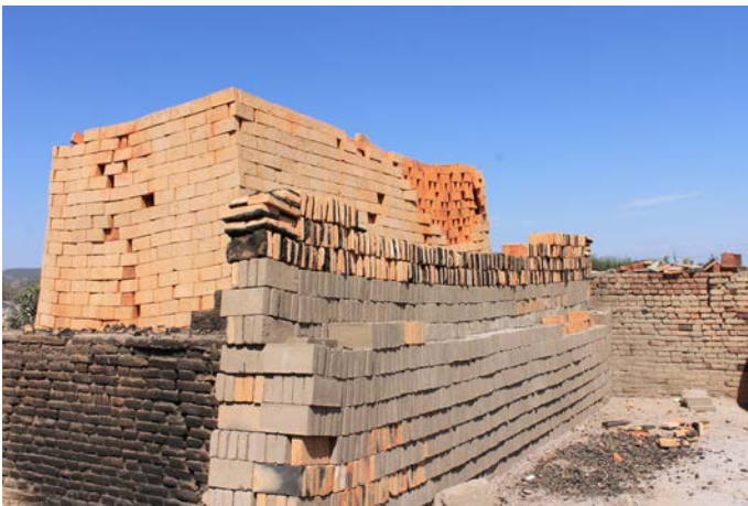
Horno ladrillero artesanal, después de la quema los ladrillos.
