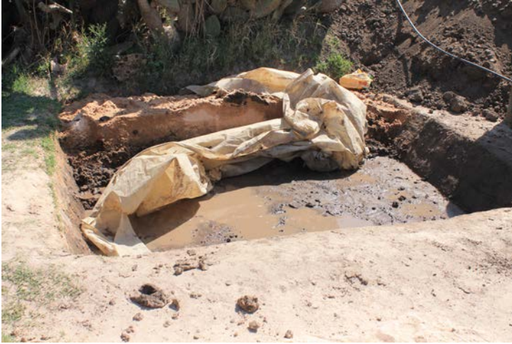
Figura 11. “Batidero” o área para preparar la mezcla de arcilla y arena.
