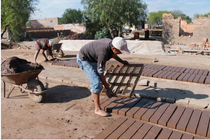
Figura 12. Tendido de ladrillos.
